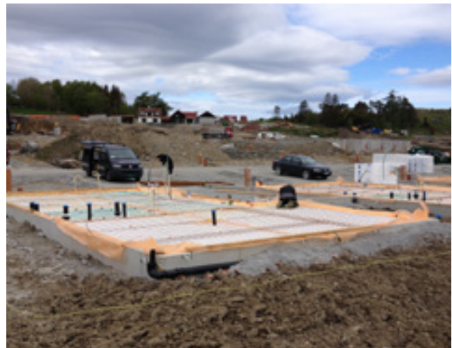
Byggeplass, boligprosjekt på Kleivane i Sandnes.
