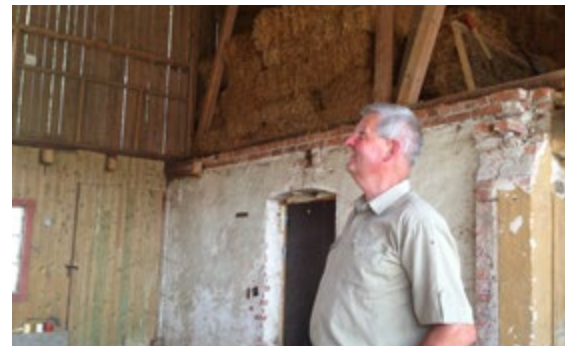
Sverre Aandstad ser på reisverket i driftsbyg- ningen, som blir restaurert
