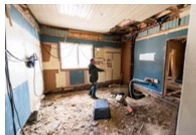
Kjøkkenet ble «strippet» helt ned til jorda. Nytt rørsystem er montert, og taket skal utbedres.
