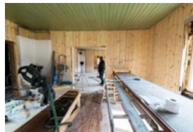
De tre stuene i første etasje kles i perlestaffpanel. Den gamle okefargen på skorstøtten viser den forrige takhøyden.
