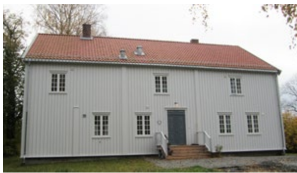
Prestegårdsbygningen sett fra gårdsplassen, slik den ser ut idag
